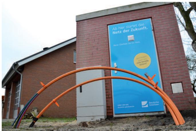
Elmlohe ist die erste Ortschaft, die ans Glasfasernetz angeschlossen wird. Im Bild ist der „Point of Presence“ (PoP) zu sehen. Die Hauptverteilstation liegt direkt neben dem Feuerwehrhaus. Sie ist vollgestopft mit Netzwerktechnik, die dafür sorgt, dass das Lichtwellensignal der Glasfaser-Hauptleitung gleichmäßig an weitere kleinere Verteilerkästen und anschließend zu jedem Hausanschluss verteilt wird
