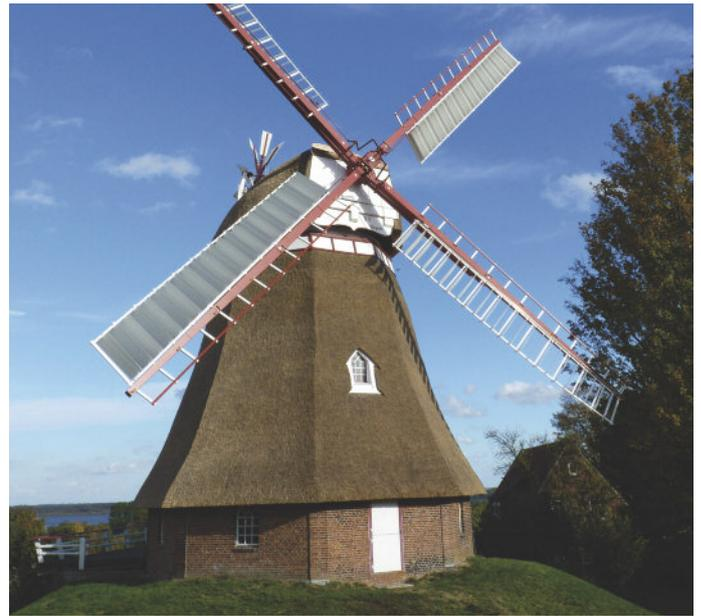
zweier Ketten am hinteren Mühlenkopf nach sich, was leider den Platz auf dem Mühlenbalkon sehr verengt. Die noch fehlenden Windbretter an den Flügeln setzen die Mühlenbautechniker erst im Frühjahr ein. Zum Schutz vor Herbst- und Winterstürmen sind die Flügel jetzt durch weitere Sicherungsmaßnahmen geschützt, so dass wir alle die Freude auf sich drehende Mühlenflügel auf das kommende Frühjahr verschieben müssen.
