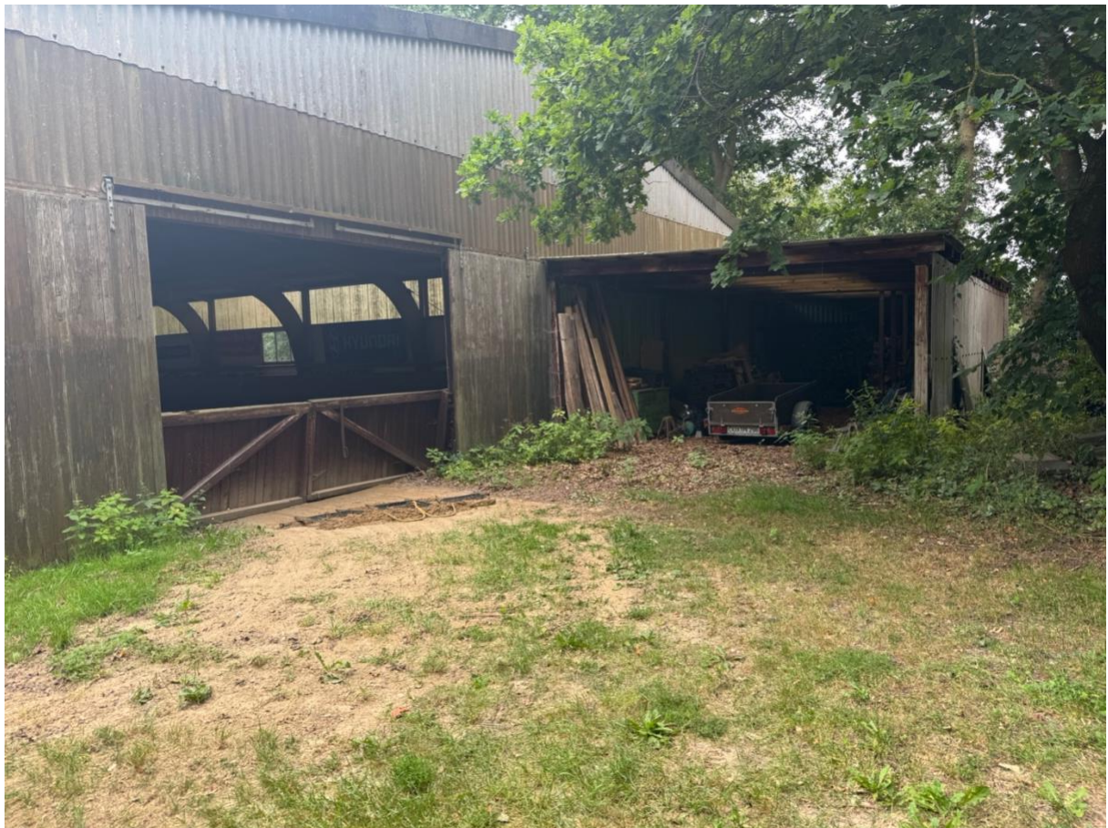
Blick auf die Reithalle
