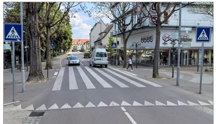
Abbildung 3: gesicherte Überquerungsstelle (FGÜ) mit Fahrbahnanhebung (Quelle: eigene Aufnahme)
