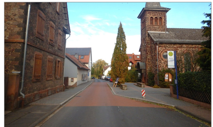
Abbildung 3: Einseitig vorgezogener Seitenraum außerhalb von Knotenpunkten mit baulicher Fahrbahnanhebung und Rotmarkierung (eigene Aufnahme)
