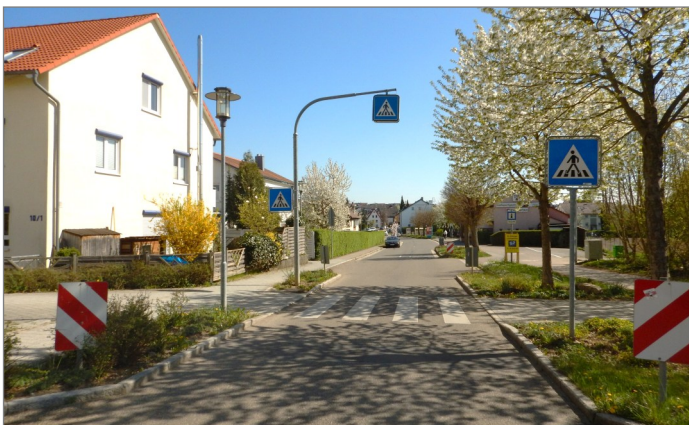
Abbildung 2: Beidseitig vorgezogener Seitenraum an Hauptverkehrsstraße außerhalb von Knotenpunkten mit Fußgängerüberweg (eigene Aufnahme)
