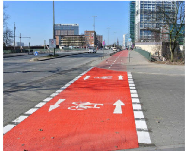
Rot eingefärbter Zweirichtungsradweg
