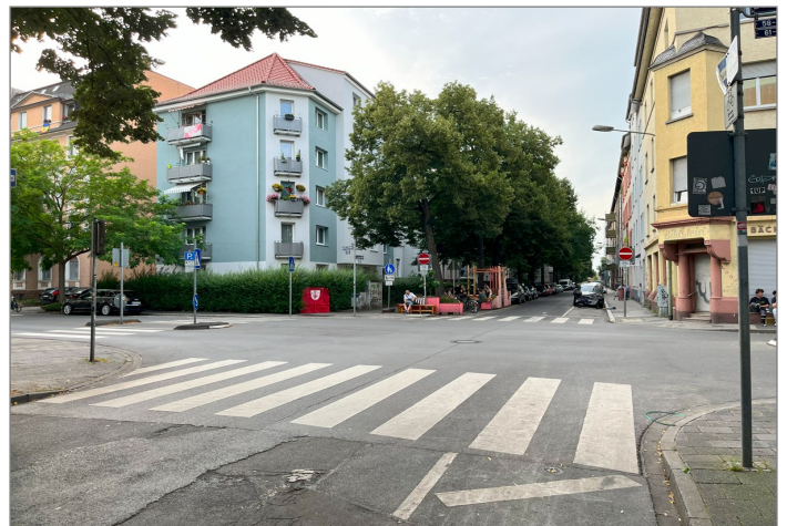
Abbildung 3: FGÜ an allen vier Knotenarmen (Quelle: eigene Aufnahme)
