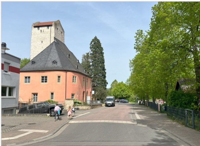
Abbildung 2: Fahrbahnanhebung zur Verkehrsberuhigung (eigene Aufnahme)
