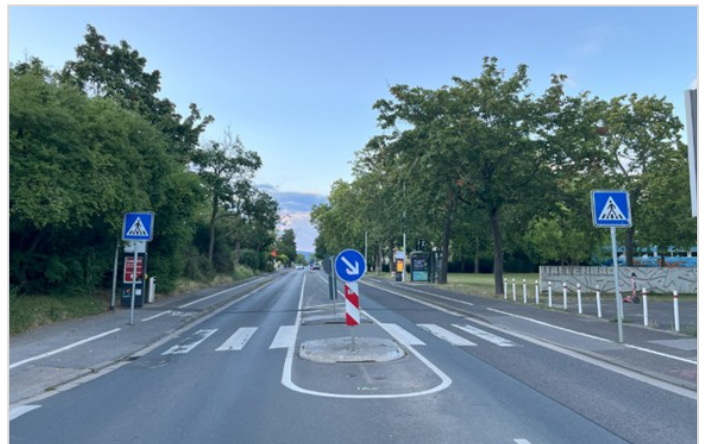
Abbildung 3: Mittelinsel mit gedübelten Elementen und FGÜ, gesicherte Überquerungsstelle, Fußverkehr bevorrechtigt (Quelle: eigene Aufnahme)
