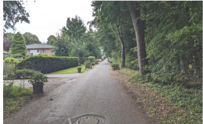
Exemplarische Situation: Erschließungsstraße ohne ausgebauten Gehweg in Langen (Holzackerweg).
