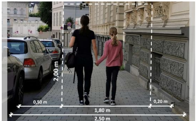
Regelmindestmaß für Gehwege mit Sicherheitsraum zur Fahrbahn, berollbarer Gehbahn mit Begegnungspuffer und Sicherheitsraum zur Bebauung (gemäß RAS 06).
