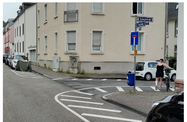
Abbildung 3: Fahrbahnanhebung und Markierung von Sperrflächen im Bereich der Einmündung (eigene Aufnahme)
