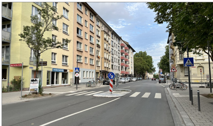
Abbildung 2: gesicherte Überquerungsstelle (FGÜ) mit Mittelinsel an Hauptverkehrsstraße (Quelle: eigene Aufnahme)
